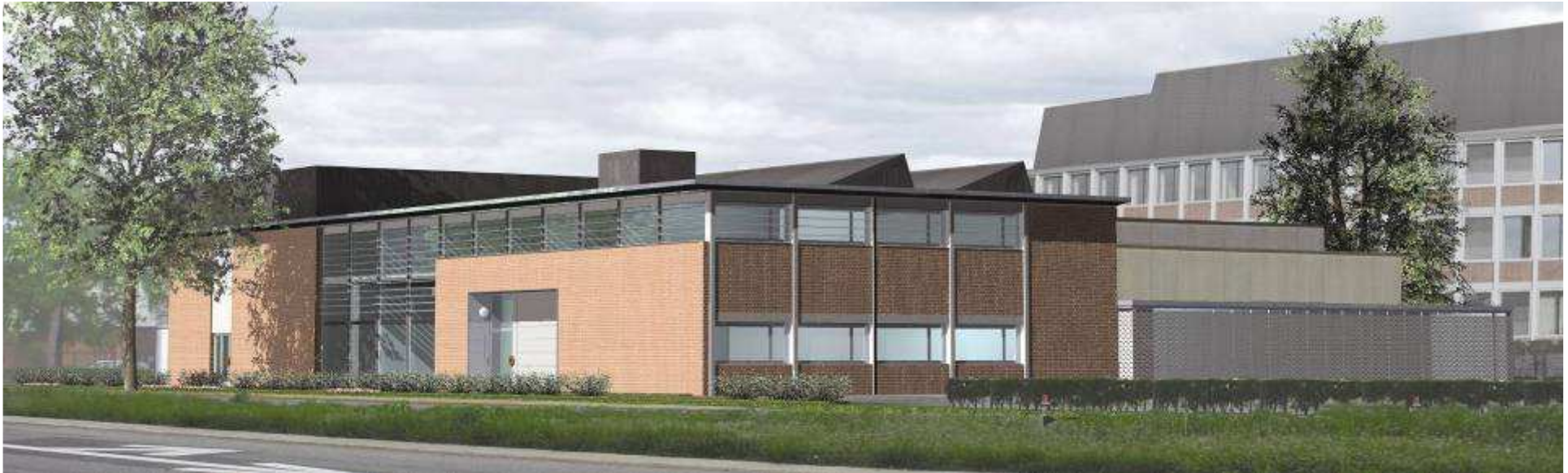
Abbildung: Motorenhaus Standort: Dübendorf
